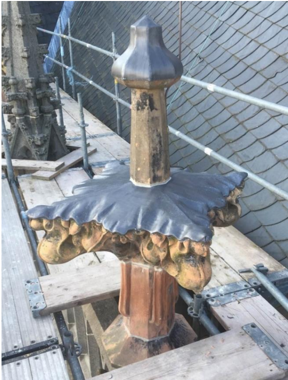
Conserveren. In dit geval geen natuursteen, maar een terracotta kruisbloem op de Domkerk in Utrecht die door een afdekking met lood wordt beschermd tegen weersinvloeden
