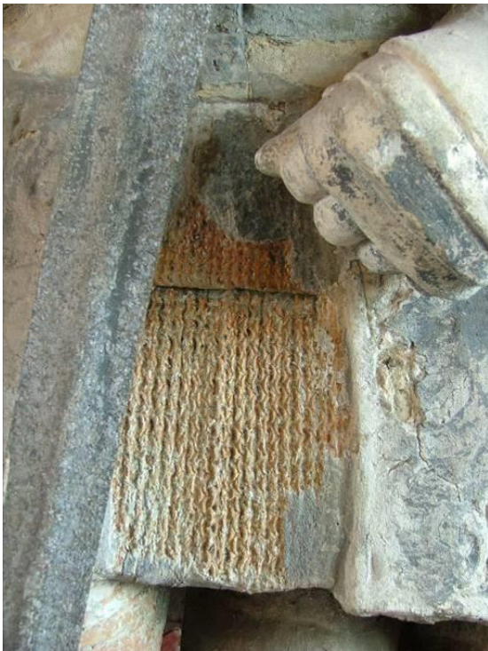
Conserveren. De beelden op het Veeerse raadhuis daterend van het begin van de zestiende eeuw en zijn gemaakt in een zachte kalksteen (Avendersteen). Ze hebben ongeveer 400 jaar de elementen getrotseerd, waarschijnlijk door het behandelen van de steen met een verf en verguldsel, waarvan op de foto nog restanten te zien zijn
