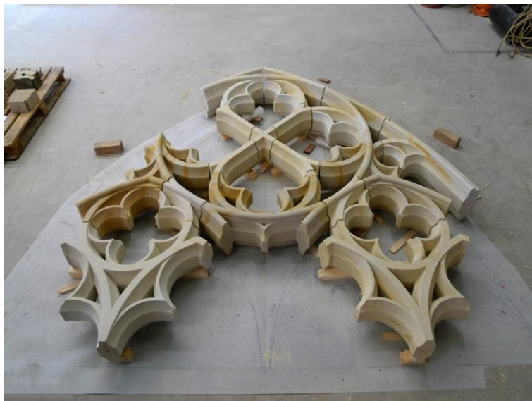
Soms is conserverend herstel niet langer mogelijk en is integrale vervanging nodig, zoals bij dit vensterharnas. Dat vergt deskundig onderzoek van materialen en vervaardigingstechniek, exacte opmeting van de bestaande situatie en daarop te baseren tekeningen en borderellen voor het nieuwe werk. In dit geval heeft vervanging plaatsgevonden met een andere steensoort. Categorie 3b
