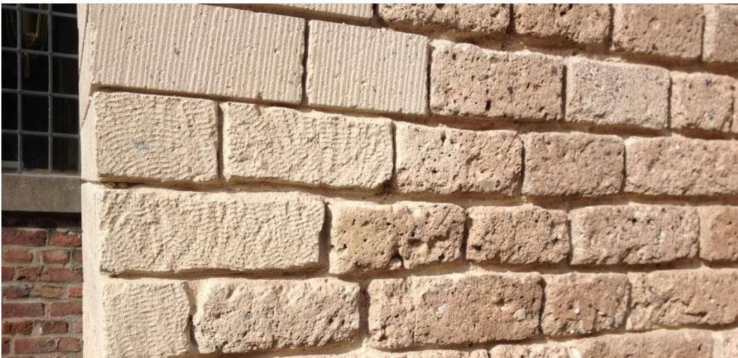
Vernieuwen. De paramentblokken aan de kerk van Hellendoorn waren van Römer tuf (rechts) en zijn deels vervangen door blokken Weiberner tuf (links). De steenhouwer had de blokken aangeleverd zoals rechtsboven te zien is, maar dit stak erg af tegen de oude omgeving. De blokken Weiberner zijn daarom ter plekke nog afgewerkt met een tandijzer (linksonder). Deze afwerking was niet aanwezig op de oude omgeving
