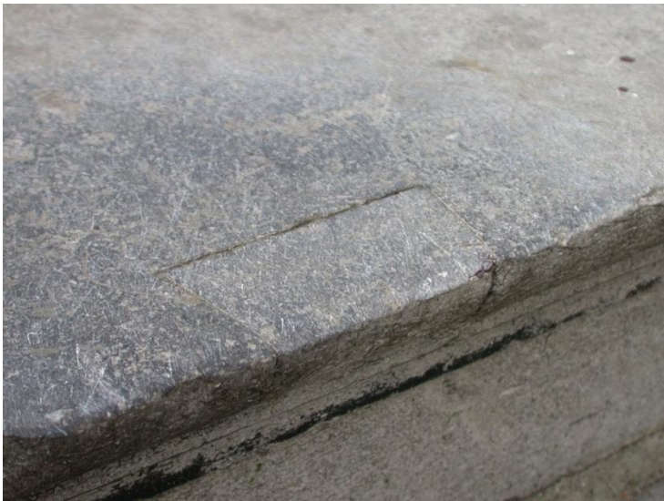
Repareren. Door middel van het inboeten van een traptrede met een zwaluwtaartvormig stukje kan een reparatie gemaakt worden die zelfs op een zwaar belaste plek, zoals deze, het lang uit kan houden
