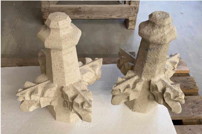
Vernieuwen. Deze kruisbloemen, die bestemd zijn voor de Domtoren in Utrecht, dateren van even na 1900 (rechts) en 2020 (links). De oude kruisbloem is van Reffroy (niet meer verkrijgbaar in 2020) en de nieuwe is uitgevoerd in Portland stone. Er zijn dus verschillen, maar deze zijn zeer gering te noemen. Strikt genomen gaat het bij de nieuwe kruisbloem om een imitatie
