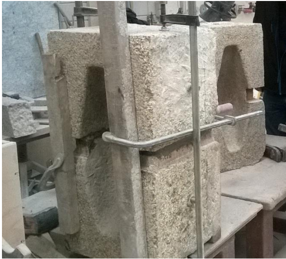
Herstelwerkzaamheden aan granieten haalkommen van een historische brug. De door roestend ijzer gescheurde onderdelen zijn verlijmd en voorzien van rvs doken. Categorie 2
