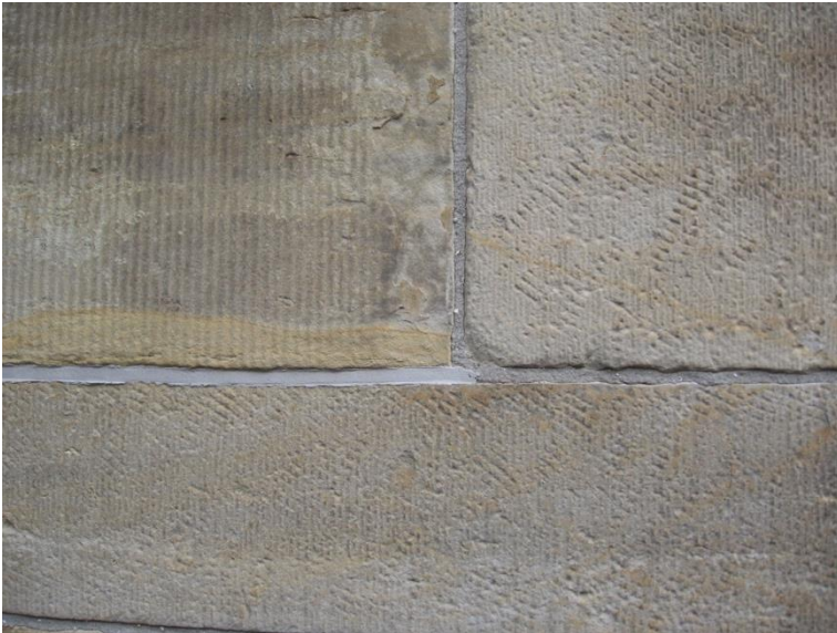
Vernieuwen. De blokken Obernkirchner zandsteen aan de voorgevel van het stadhuis van Leiden laten twee verschillende afwerkingen zien. De blokken die bij de herbouw na 1930 zijn geplaatst (rechts en onder) zijn anders bewerkt dan de blokken die gespaard bleven (linksboven)
