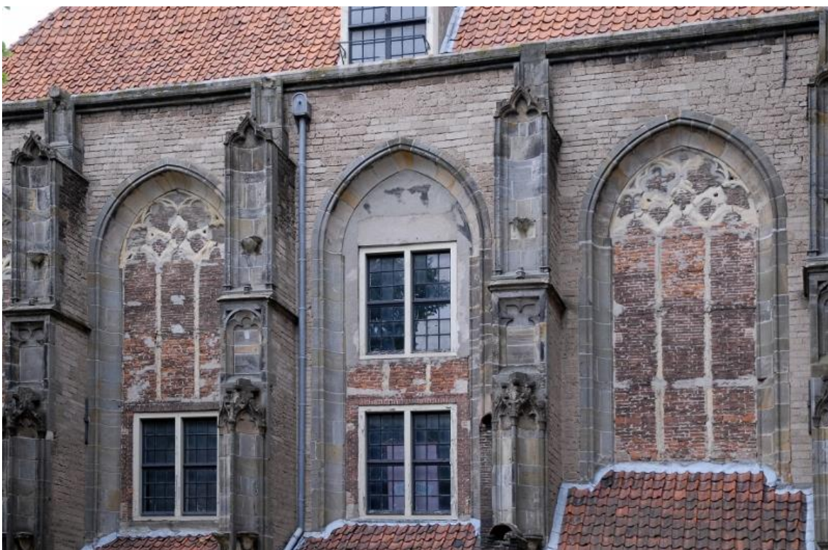
Bij consolidatie en restauratie van een situatie als deze (Mariakerk, Deventer) is vooraf een deskundige analyse en afweging nodig over de inhoud van het werk. De keuze per geveldeel voor behoud, vervanging, herstel en/of reparatie maken de opgave complex. Zorgvuldige opname en verantwoording van aanpak zijn een voorwaarde voor vergunning en uitvoering. De traceringen zijn van Baumberger steen en middeleeuws. De Ettringer tufsteen aan de contreforts dateert van het Interbellum. Er zijn dus meerdere tijdslagen zichtbaar aan het gebouw
