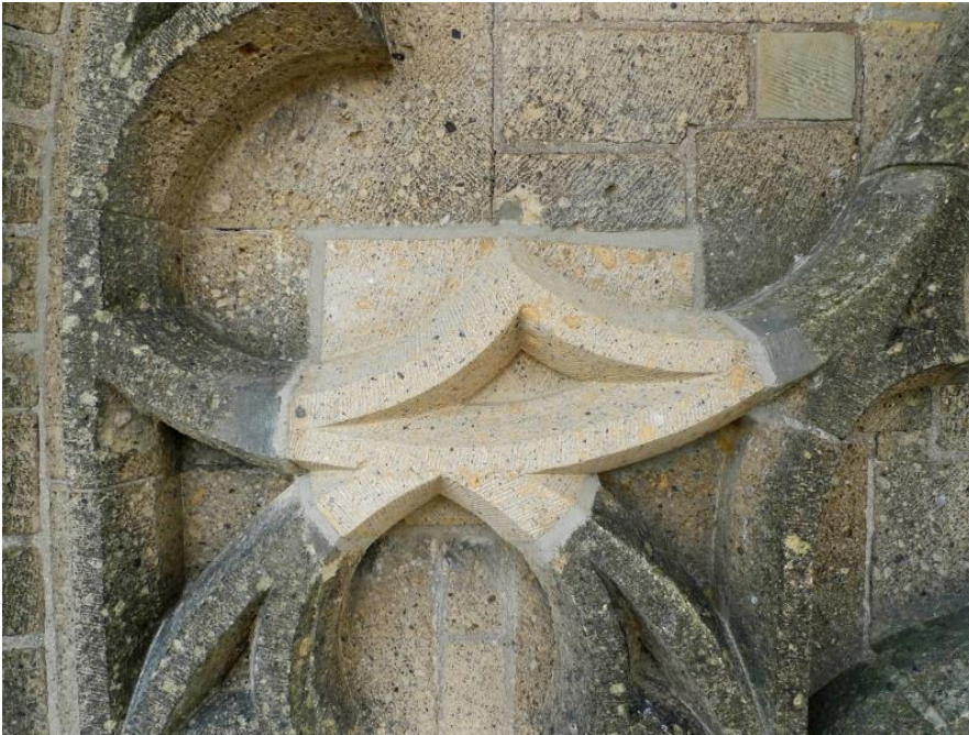
Vernieuwen. Restauratie van tufstenen blindtracering aan de Jacobitoren in Utrecht. Het aangetaste blok met toot is vervangen door een andere tufsteen. Omdat hier een element als geheel is vervangen, spreekt men in het kader van deze URL over 'Vernieuwen' en niet 'Repareren' (in dit geval categorie 3b: 'Imiteren')
