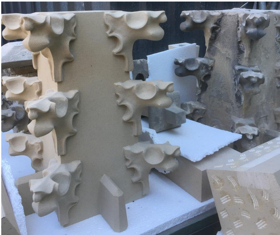
Vernieuwen. Pinakels voor de Sint Jan in Den Bosch van Udelfanger zandsteen. Op de achtergrond een pinakel van 1870, op de voorgrond een pinakel gemaakt in 2020. De oude pinakel is volledig handmatig geproduceerd, de nieuwe met een combinatie van machines en handgereedschappen. Strikt genomen is de nieuwe pinakel dus een imitatie, maar het nieuwe en het oude werk verschillen nauwelijks van elkaar
