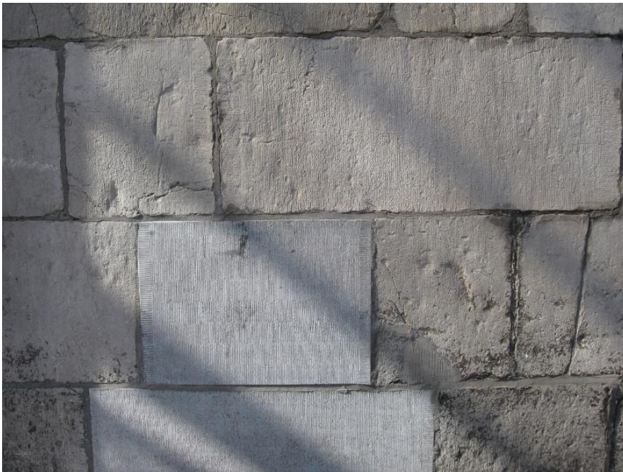
Vernieuwen. De oude blokken Naamse steen aan de gevel van het stadhuis van Maastricht zijn eerst met de hand vlak gemaakt en daarna pas gefrijnd. Recente vervangingen met Ierse hardsteen (midden en midden onder) zijn vlak gezaagd en daarna gefrijnd. Het eindresultaat sluit niet goed aan bij de oorspronkelijke omgeving, omdat het de onvolkomenheden van het handwerk mist en het materiaal anders is. Het gaat hier om een imitatie
